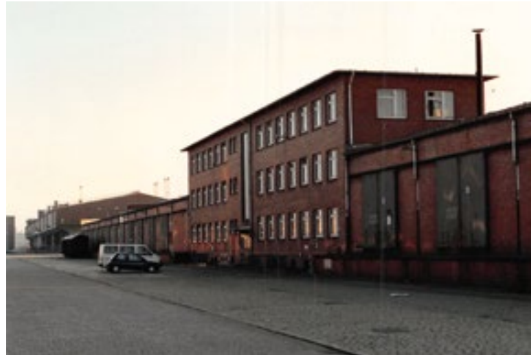
Schuppen 3 im Europahafen, erster Standort des ODP Kernlagers
