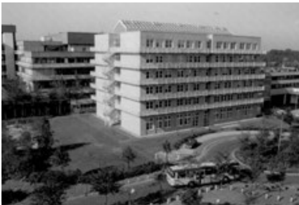
Gebäude GEO1 kurz nach der Fertigstellung 1989
