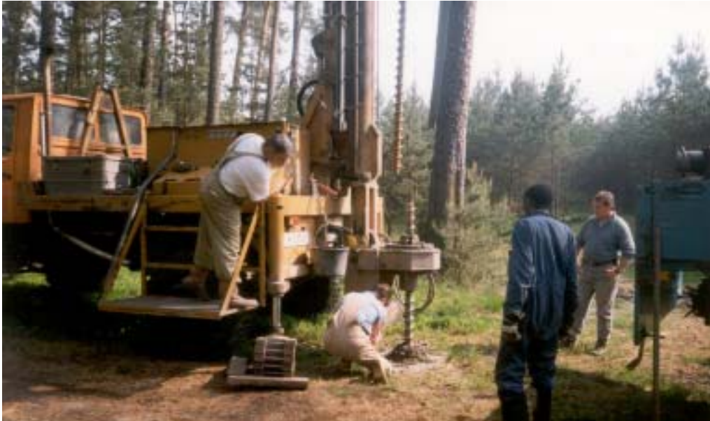
Geologische Landesaufnahme: Bohrung mit schwerem Gerät
