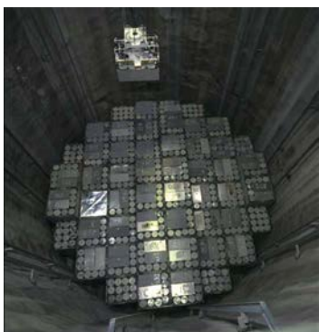
Schwach- und mittelradioaktiver Abfall; Endlager Olkiluoto, Finnland. @SKB
