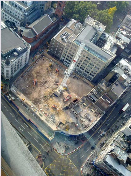
Baustelle des Crossrail-Bahnverkehrsprojektes an der Station Tottenham Court Road; London.
