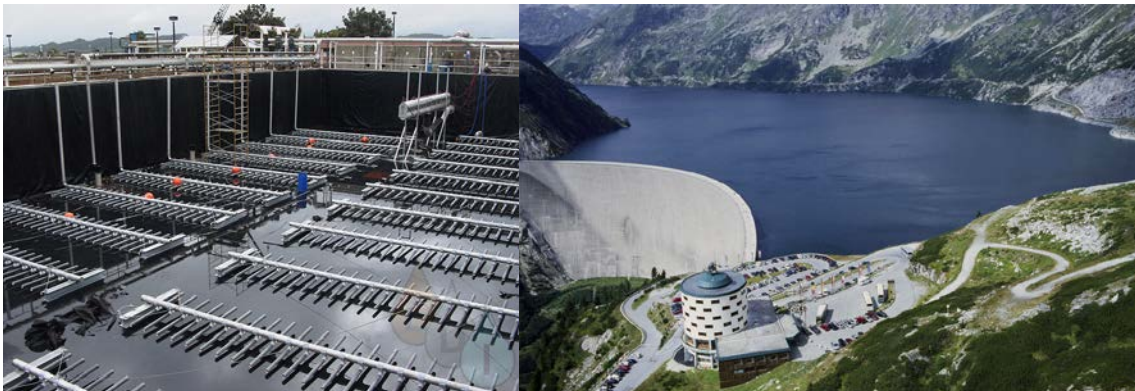
Abwasserbehandlungssystem und Kölnbrein-Sperre und Pumpspeicher-Kraftwerk; Kärnten, Österreich.
